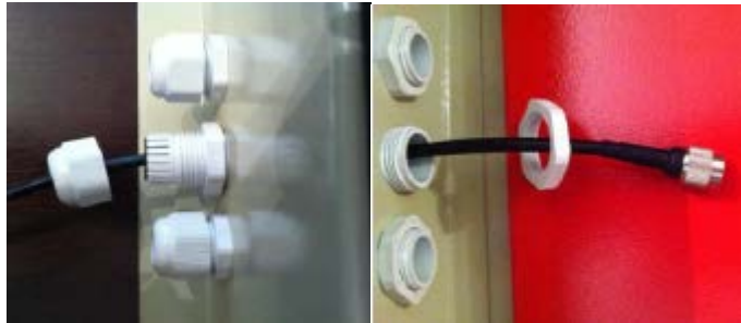
Ensamble para el Conector de la Antena LMR400
