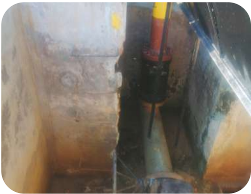
Inspección Técnica a la Lateral Gasoducto GCY - ENDE (Valle Hermoso - Carrasco) DCVH
