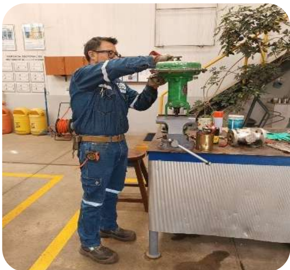
Imagen N° 11: Refinería Gualberto Villarroel Mantenimiento preventivo válvula LV 1202
