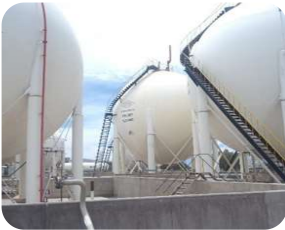
Imagen N° 13: Refinería Gualberto Villarroel - Diques de contención concluido para todas las esferas excepto 1TK 2936; 1TK 2937 en ejecución al 60%
