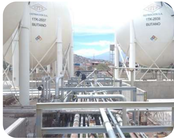
Imagen N° 14: conclusión montaje líneas PCOLP; OSSA I; Descarga GLP; BUTANO TK 2937; GLP SUCCION; GLP TK 2940; BUTANO TK 2938
