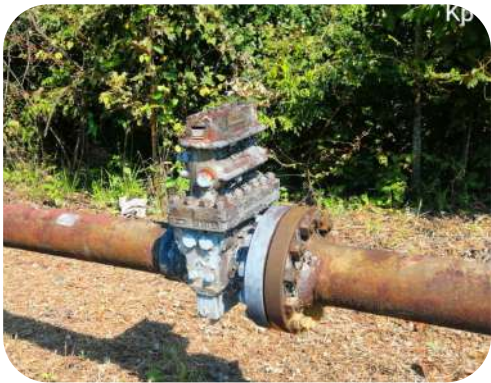
Inspección Técnica a la Lateral Gasoducto Bulo Bulo - GCY (LGBB)
