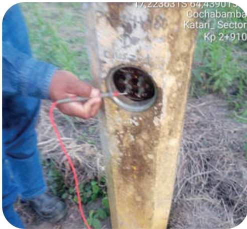
Inspección Técnica a la Lateral Gasoducto Katari (LGKT)
