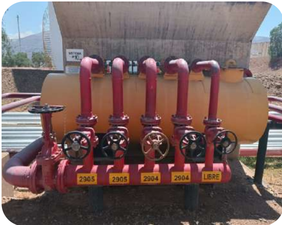
Imagen N° 7: Refinería Gualberto Villarroel - Sistema de Seguridad contra incendios Área Tanques de Producción
