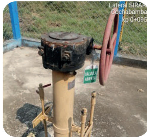
Inspección Técnica a la Lateral Gasoducto Sirari (LGSi)
