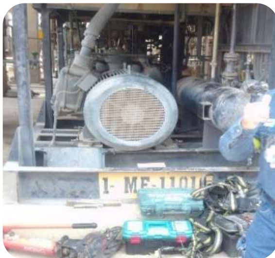
Imagen N° 12: Refinería Gualberto Villarroel Reemplazo motor Equipo ME - 1101-A
