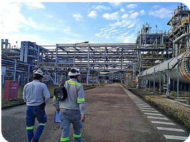
Supervisión a la Planta de Amoniaco y Urea
