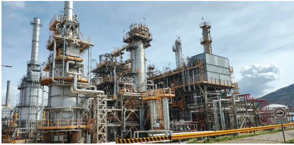
Imagen N° 11: Refinería Gualberto Villarroel – Unidad 22500 Inspección Visual
