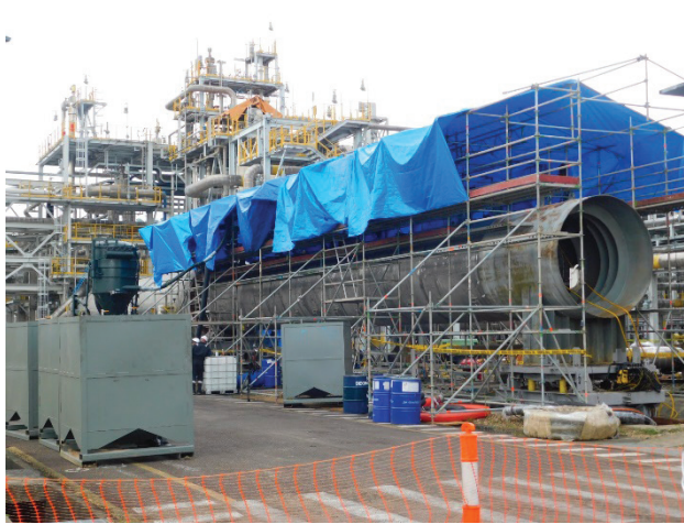
Imagen N° 2: MANTENIMIENTO CONVERTIDOR 105-D PLANTA DE AMONIACO Y UREA “MARCELO QUIROGA SANTA CRUZ”
