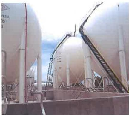
Imagen N° 13: Refinería Gualberto Villarroel – Diques de contención concluido para todas las esferas excepto 1TK 2936; 1TK 2937 en ejecución al 60%
