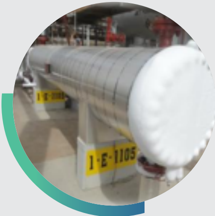
Trabajos Enfriador 1E-1105
