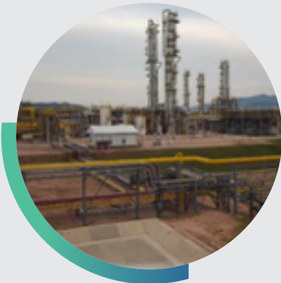
Planta de Separación de Líquidos “Carlos Villegas Quiroga” - PSLCV
