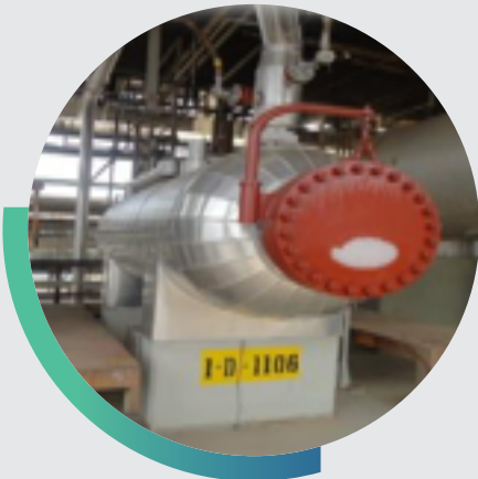
Trabajos Acumulador 1D-1106
