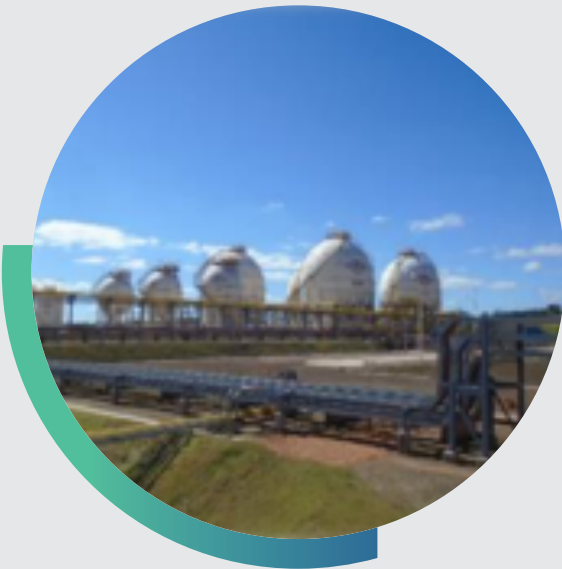
PSLCV, unidad de almacenaje de GLP
