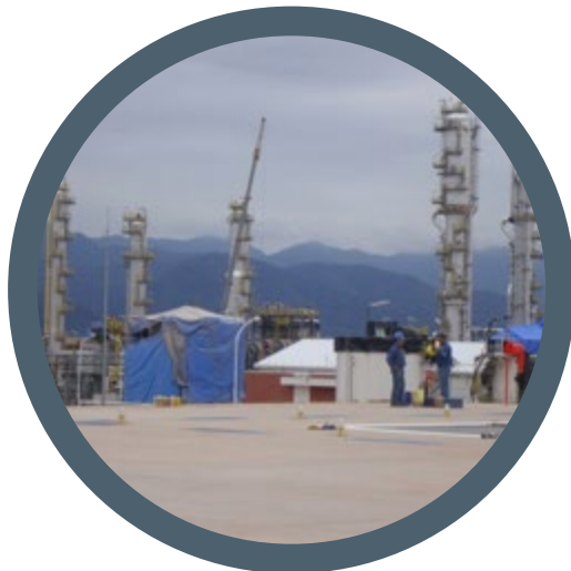
PSL Carlos Villegas – Columnas de Fraccionamiento
