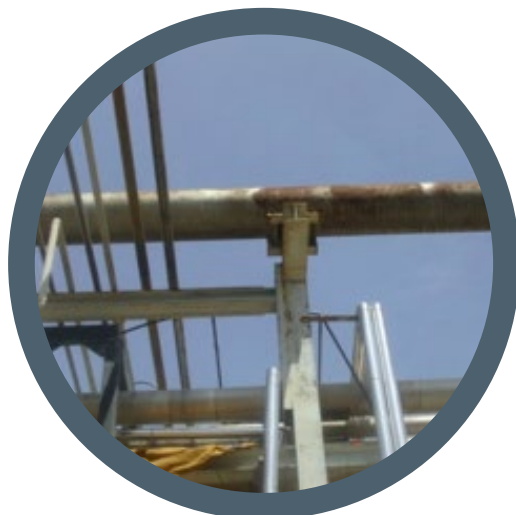
Montaje e instalación de los Tie In
