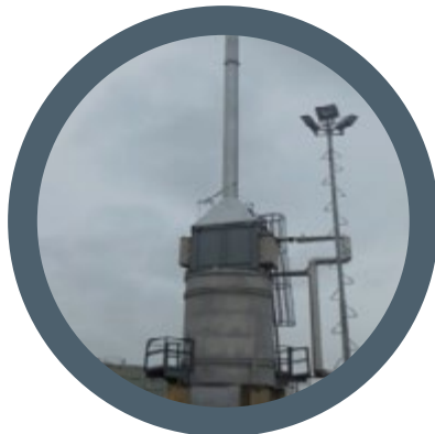
HT-0301 Horno – Cambio caja de convección y los tubos de la zona radiante
