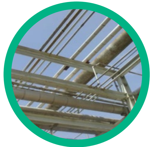
Montaje e instalación de los Tie In
