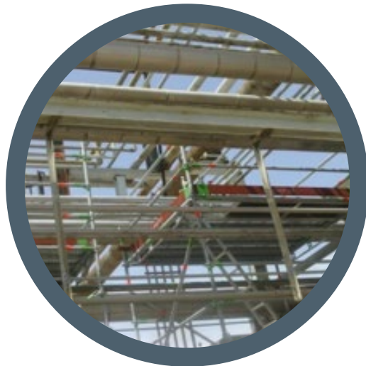
Montaje e instalación de los Tie In
