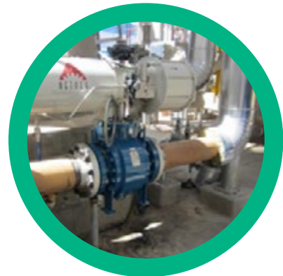
Reemplazo de Válvulas Unidad de Crudo 12 500 BPD
