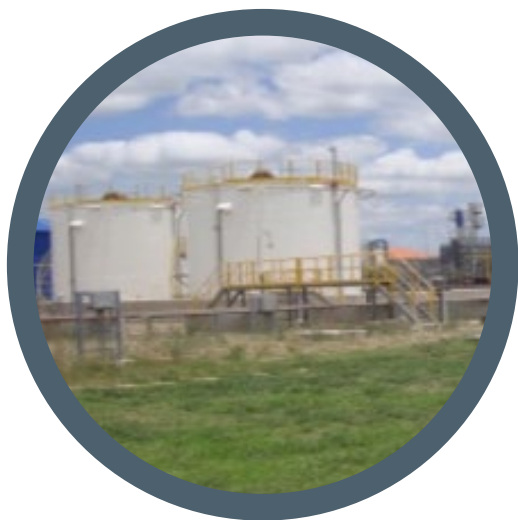
PSL Rio Grande – Tanques Gasolina Estabilizad
