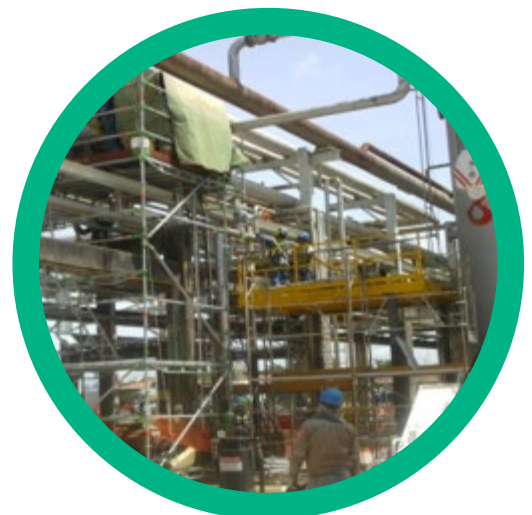
Montaje e instalación de los Tie In de Interconexión para el suministro
