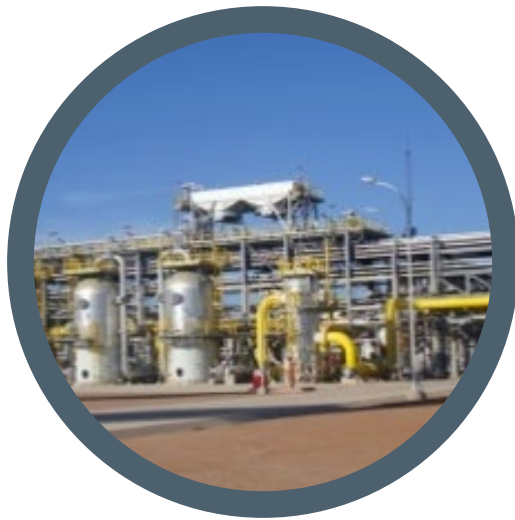
PSL Carlos Villegas – Filtrado y deshidratado del GN
