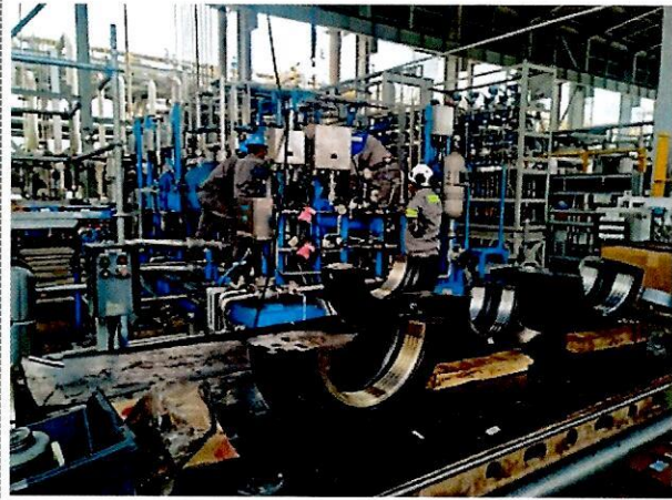
IMAGEN N°8: MANTENIMIENTO MAYOR 105-TJ PLANTA DE AMONIACO Y UREA "MARCELO QUIROGA SANTA CRUZ"
