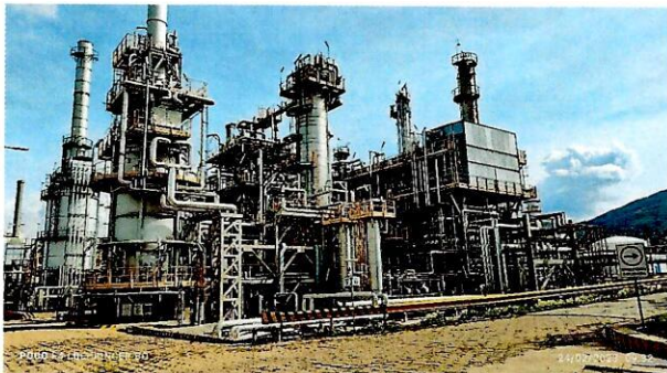
Imagen N° 11: Refinería Gualberto Villarroel – Unidad 22500 Inspección Visual
